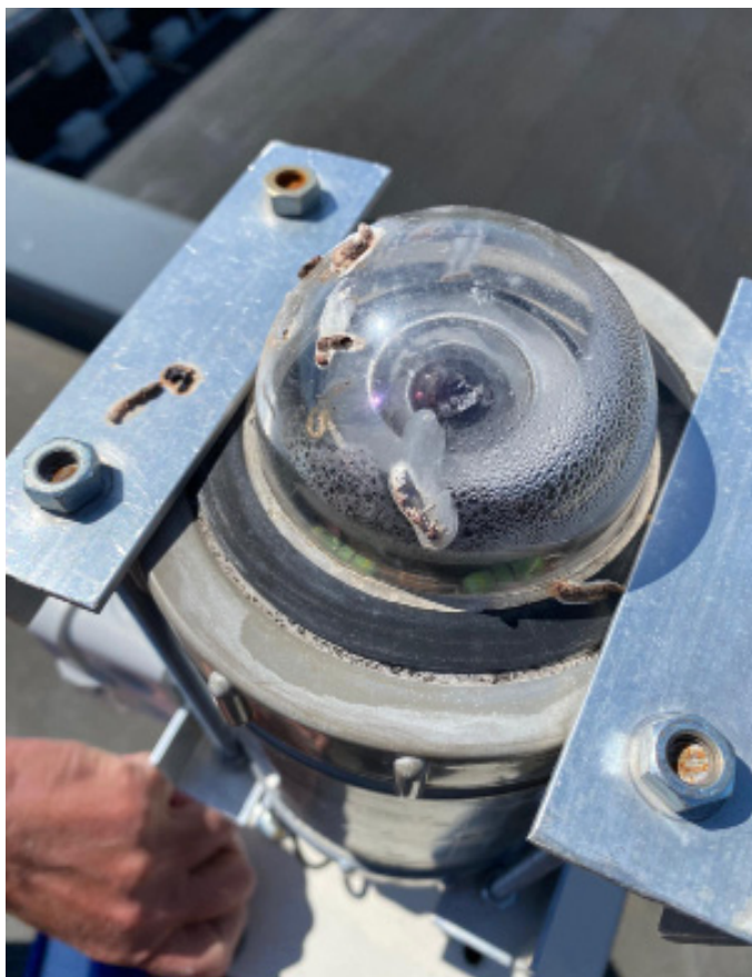
Figuur 2. Zó troffen we de all-sky in Dourbes aan. Zonder plaatselijke support kun je geen remote station plaatsen!
