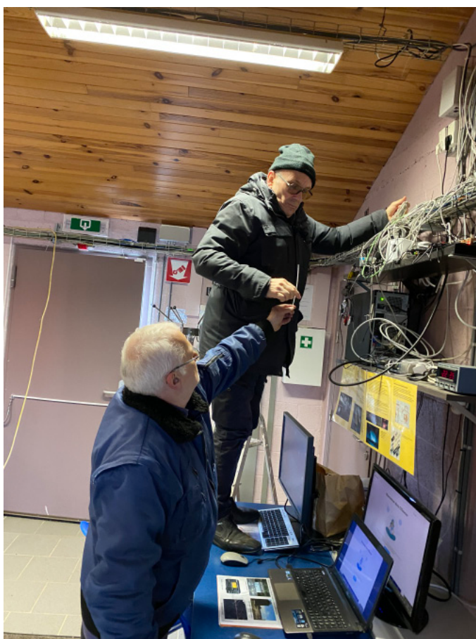
Figuur 4. De aansluitingen in de sterrenwacht worden gemaakt.
