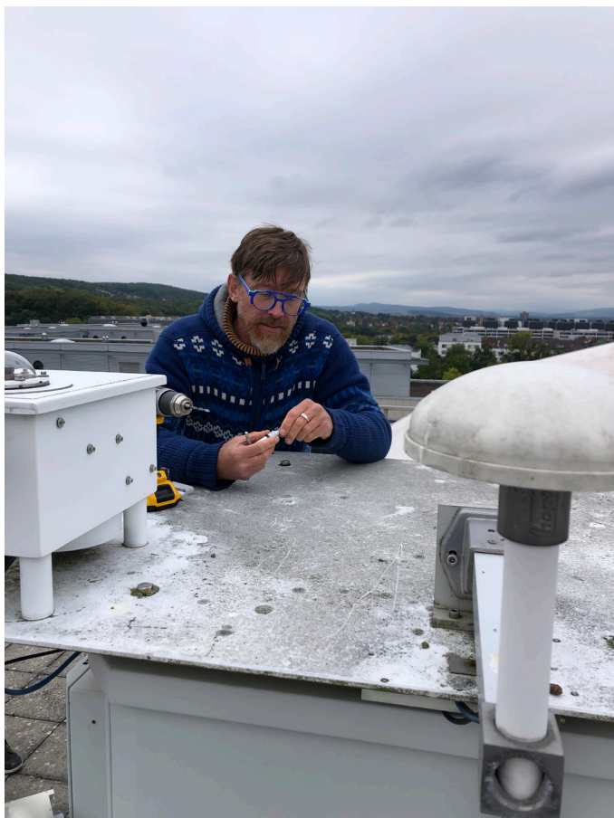
Figuur 4. Felix tapt de schroefdraad in het dakplateau waarmee de 917 in Göttingen wordt bevestigd.
