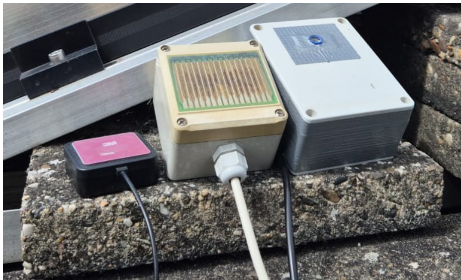
Figuur 5. Opstelling op het schuurdak met van links naar rechts de GPS-antenne, de geleidingssensor en de nabij-infraroodsensor.
