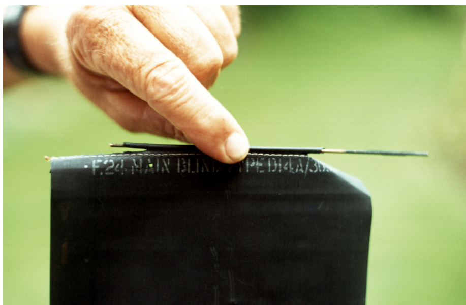
Figuur 2. De sluiterdoeken waren niet allemaal in topconditie. Delen ervan zijn opnieuw gemaakt met dun rubberdoek (1979)
