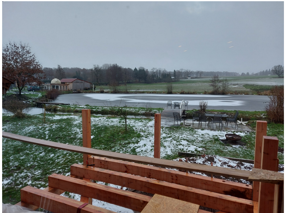
Figuur 1. Blik richting zuid vanaf het toekomstige balkon van de woning. Links achter de locatie voor de Watecs en de RMS cameras.
