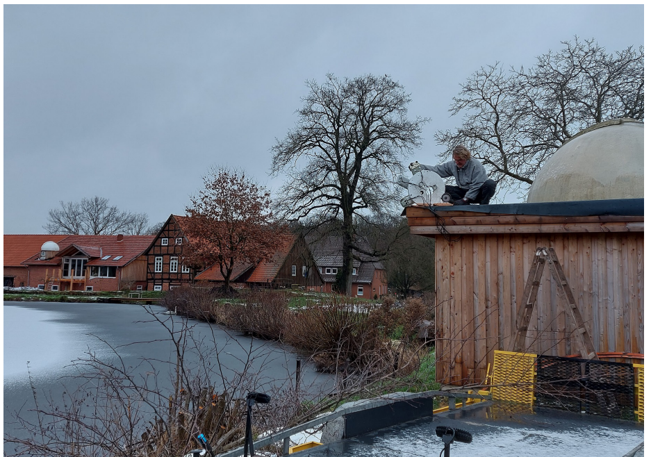
Figuur 2. Blik richting noord vanaf de sterrenwacht. Romke installeert hier de 3 CAMS op het dak.
