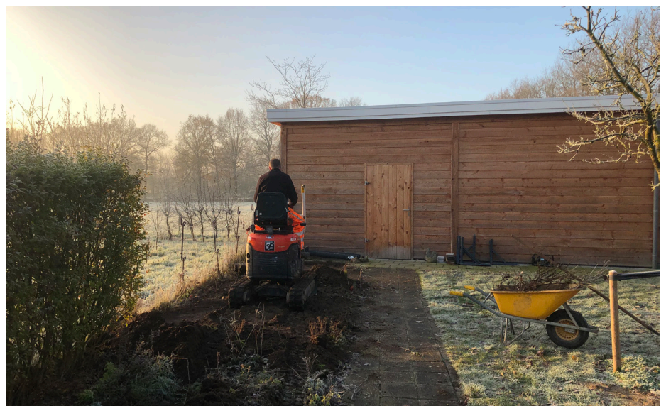
Figuur 2. Het waarnemingsplatform wordt aangelegd.
