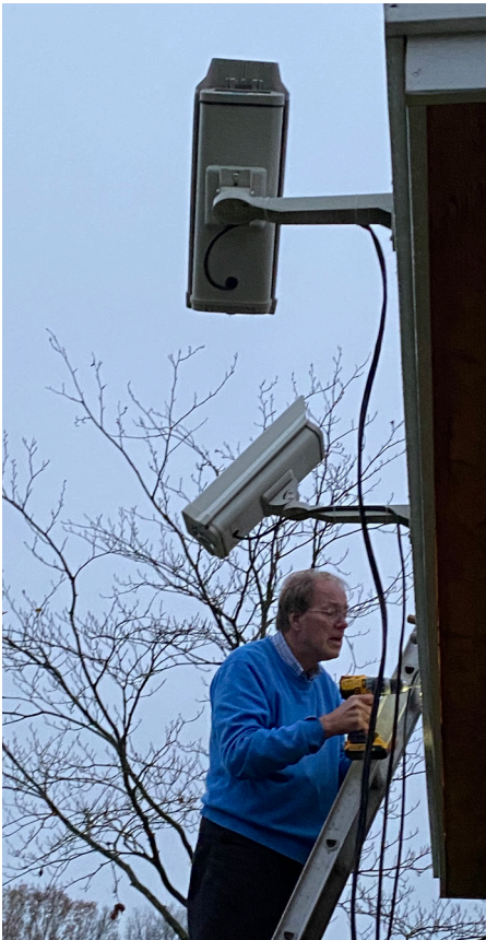
Figuur 3. De CAMS toestellen bestrijken op 40 graden hoogte een strook van ZW via W naar N.
