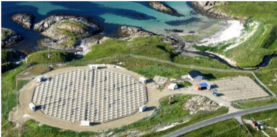
Figuur 3 en 4: MAARSY radar systeem, van dichtbij en vanuit de lucht.
