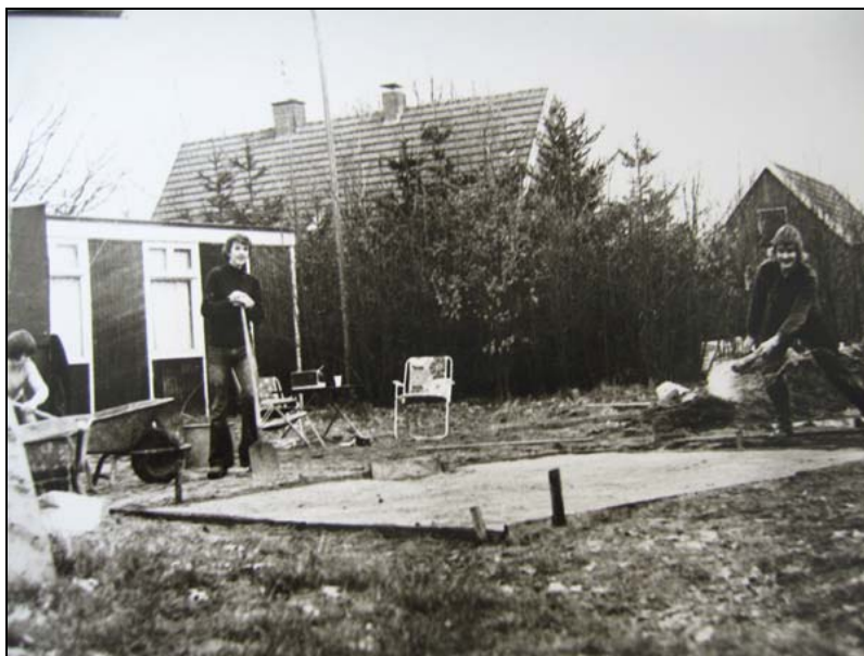
Foto 3: Het storten van de betonvloer in maart 1978. Vlnr Ralf Mulder, Peter van Ommen en Romke Schievink.
