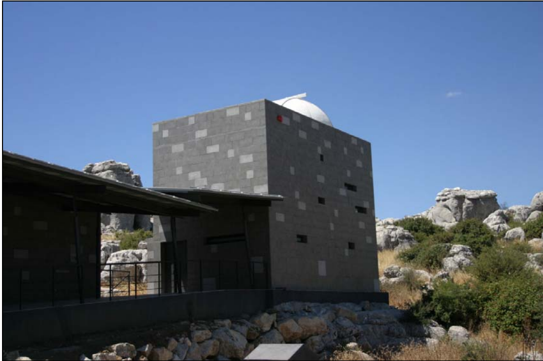
Foto 10: Het nieuw in aanbouw zijnde observatorium in het natuurpark El Torcal.
